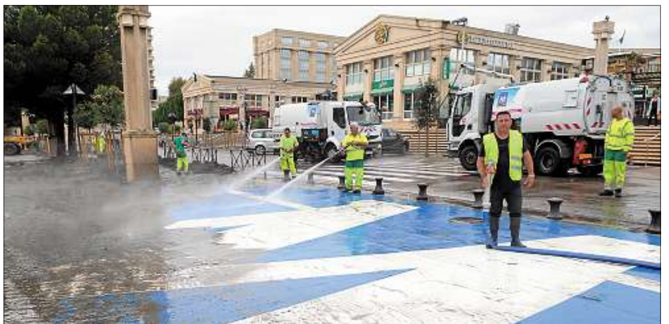
■ Les services de la Ville de Montpellier étaient à pied d'œuvre hier pour effacer les stigmates des pluies diluviennes. Photo J.-M. MART
